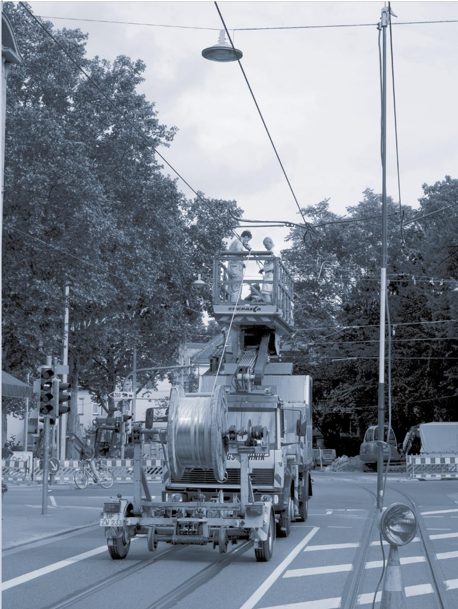
Erneuerung Fahrleitungen in Handschuhsheim
